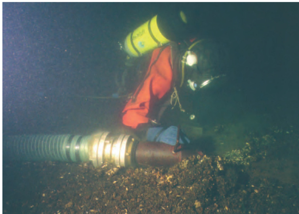
Saugarbeiten unter Wasser.
