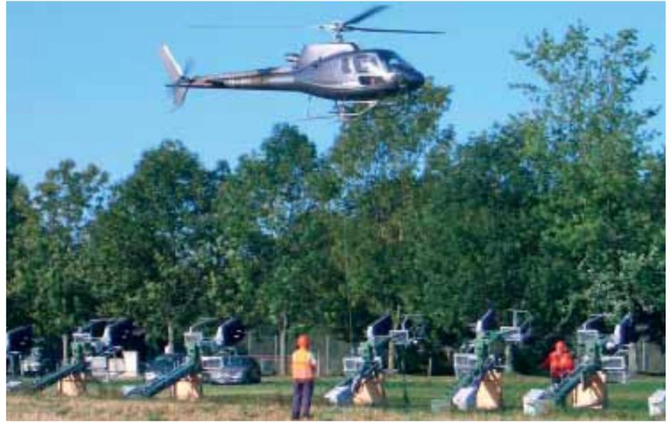
Für Hubschrauber kein Problem: Zum Bau einer neuen Bahnstrecke werden hier Signalmasten aufgenommen.
