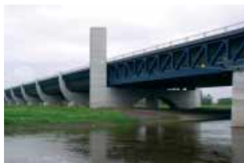
Die Kanalbrücke über die Elbe bei Magdeburg.
