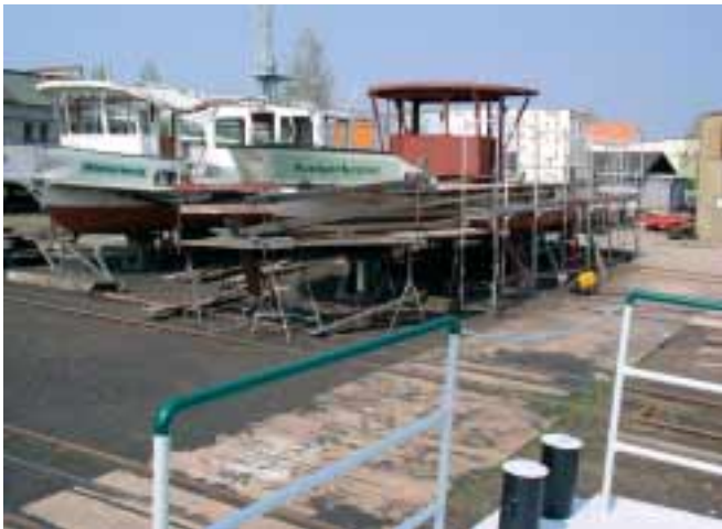
In der Schiffswerft Laubegast AG werden zur Zeit drei Personenfähren (für je 120 Fahrgäste) für die Oberelbische Verkehrsgesellschaft Pirna-Sebnitz mbH wieder auf- bzw. neu gebaut.
