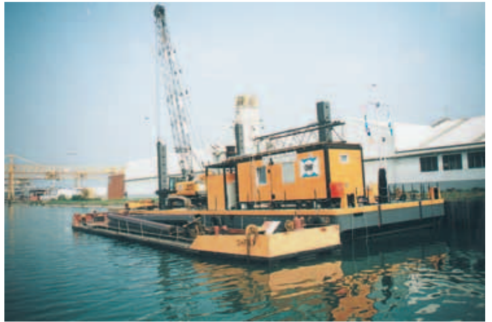
Der 35 m lange Ponton der Firma OHF ist jetzt mit Bagger und Ramme bereits im Arbeitseinsatz.
