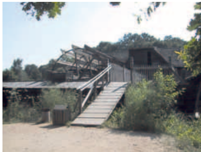
Eine nachgebaute ungarische Schiffsmühle im Internationalen Mühlenmuseum in Gifhorn
