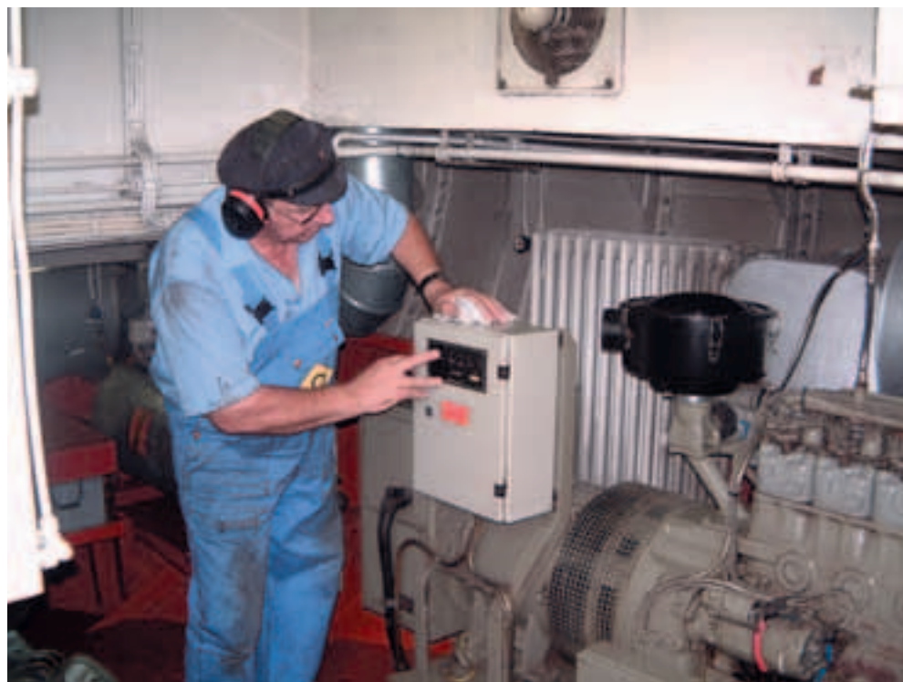
Der Gehörschützer ist im Maschinenraum ein wichtiger Schutz, denn schon eine einmalige hohe Lärmeinwirkung kann das Gehör auf Dauer schädigen.
