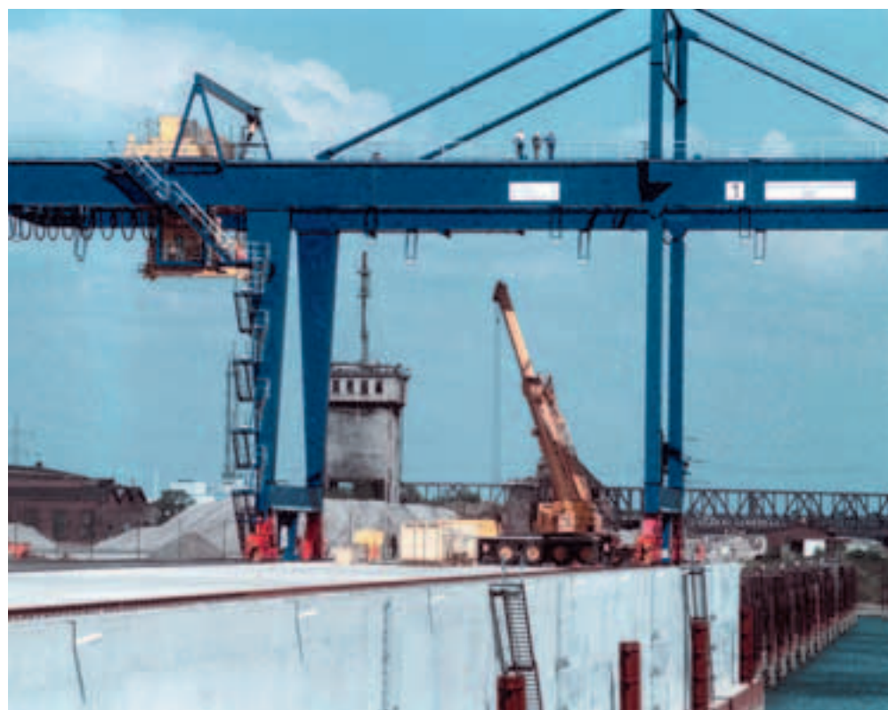
Die Krananlage auf „Logport“ in Duisburg-Rheinhausen ist errichtet, das Hafenbecken nach einer Erneuerung wieder arbeitsfähig.
