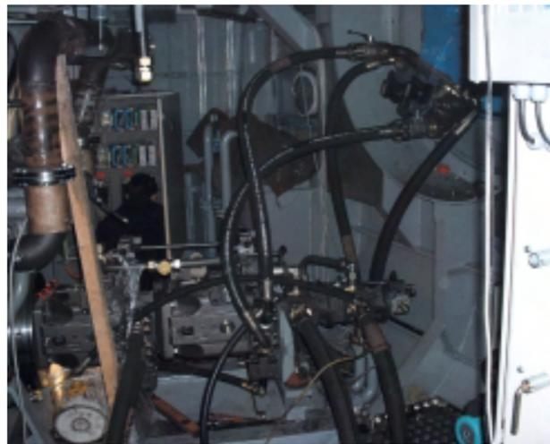
Hydraulikleitungen müssen ohne Scheuerstellen verlegt werden.
