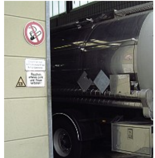
Organisatorischer Explosionsschutz: Kennzeichnung der Einfahrt einer Tankfahrzeugreinigungsanlage als explosionsgefährdeter Bereich
