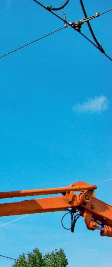
Wenn unterschiedliche Potenziale dicht beieinanderliegen, sind benachbarte, unter Spannung stehende Teile abzudecken oder abzuschränken.
