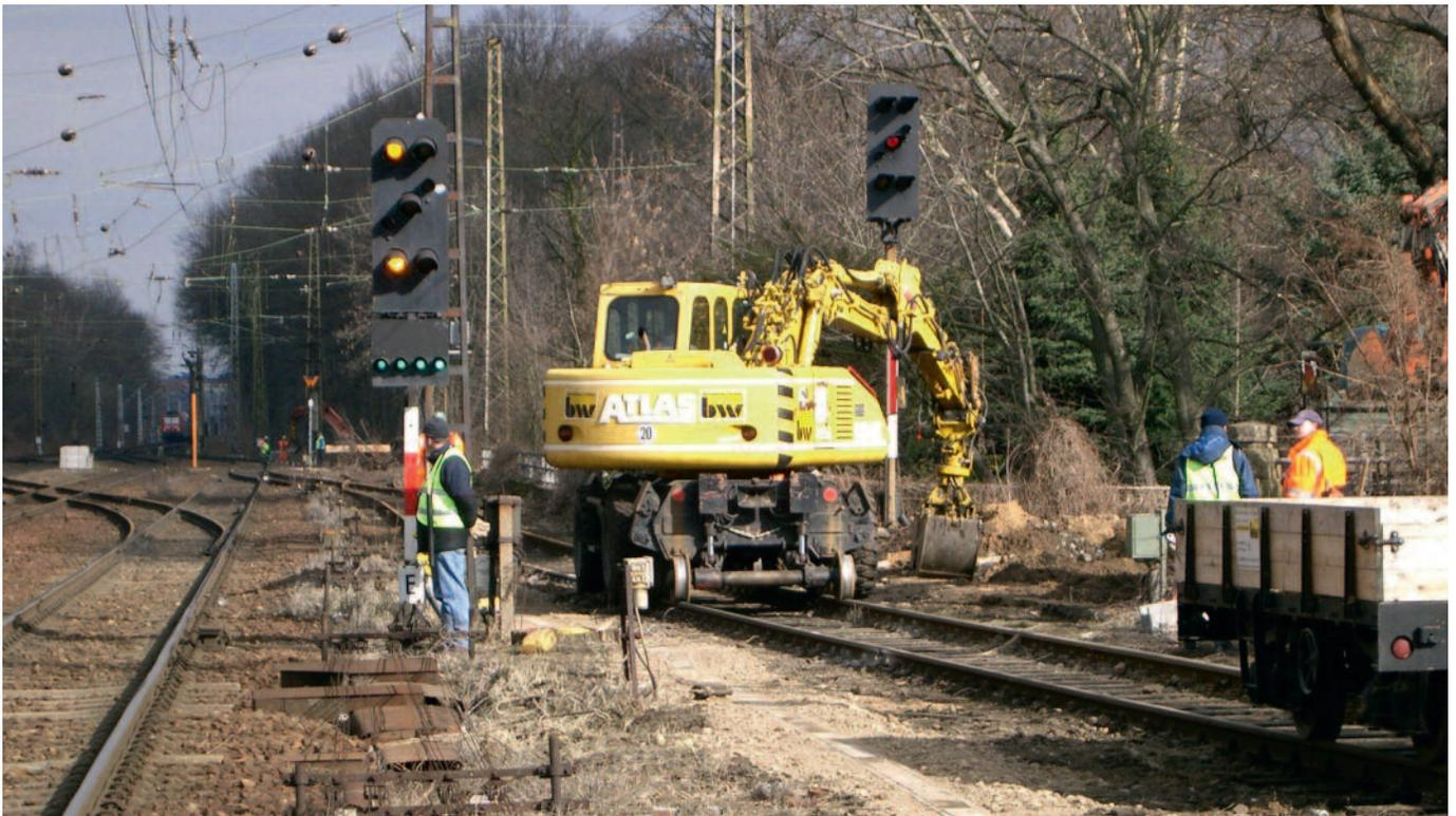
■ Die sichere Durchführung des Eisenbahnbetriebes macht es erforderlich, an und in der Nähe von Gleisen regelmäßig Instandhaltungsarbeiten an der Infrastruktur durchzuführen. Für die Beschäftigten bestehen bei diesen Arbeiten Gefährdungen durch bewegte Schienenfahrzeuge und gegebenenfalls durch die Oberleitung.
