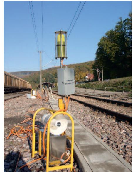
Die technisch sicheren automatischen Warnsysteme kündigen der Arbeitsstelle zuverlässig die sich nähernden Zugfahrt an.
