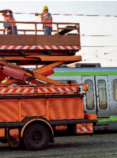
*Bei Arbeiten mit direktem Kontakt zum unter Spannung stehenden Fahrdrabt ist eine funktionierende doppelte Isolation des Fahrzeuges lebenswichtig.*
