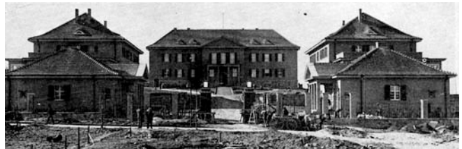
Abb. 32 Der Bau des neuen deutschen Botschaftsgebäudes in Ankara 1928
