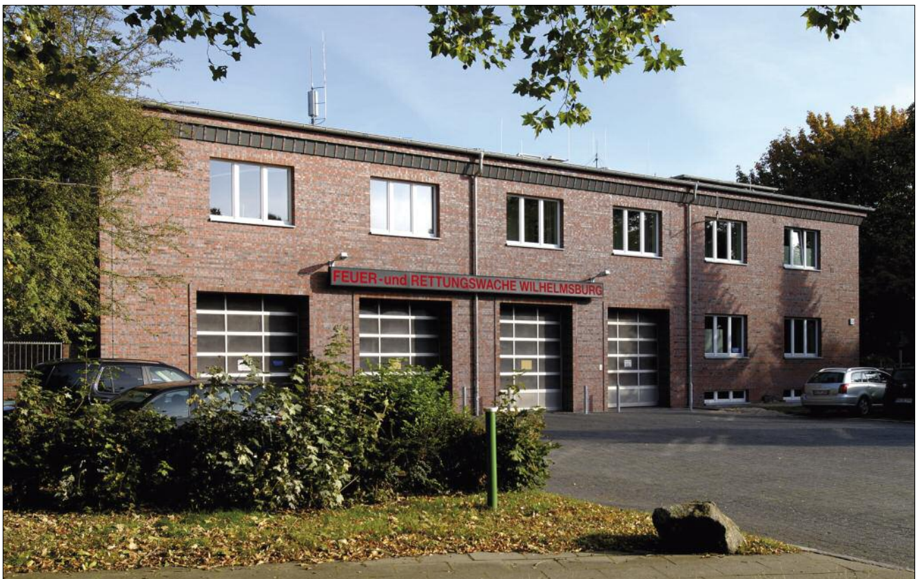
2009 am Dach und an der Fassade modernisiert: Die Feuer- und Rettungswache Wilhelmsburg heute
