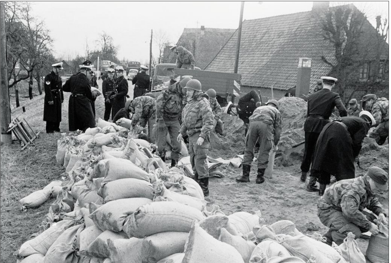
Deichbrüche in Altenwerder: Die Einsatzkräfte von Feuerwehr, Polizei und Bundeswehr waren tagelang unermüdlich im Einsatz
