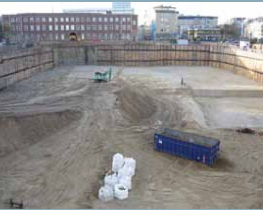
Baugrube für das IKEA-Einrichtungshaus
