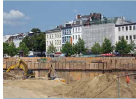
Blick in die Baugrube an der Großen Bergstraße.
