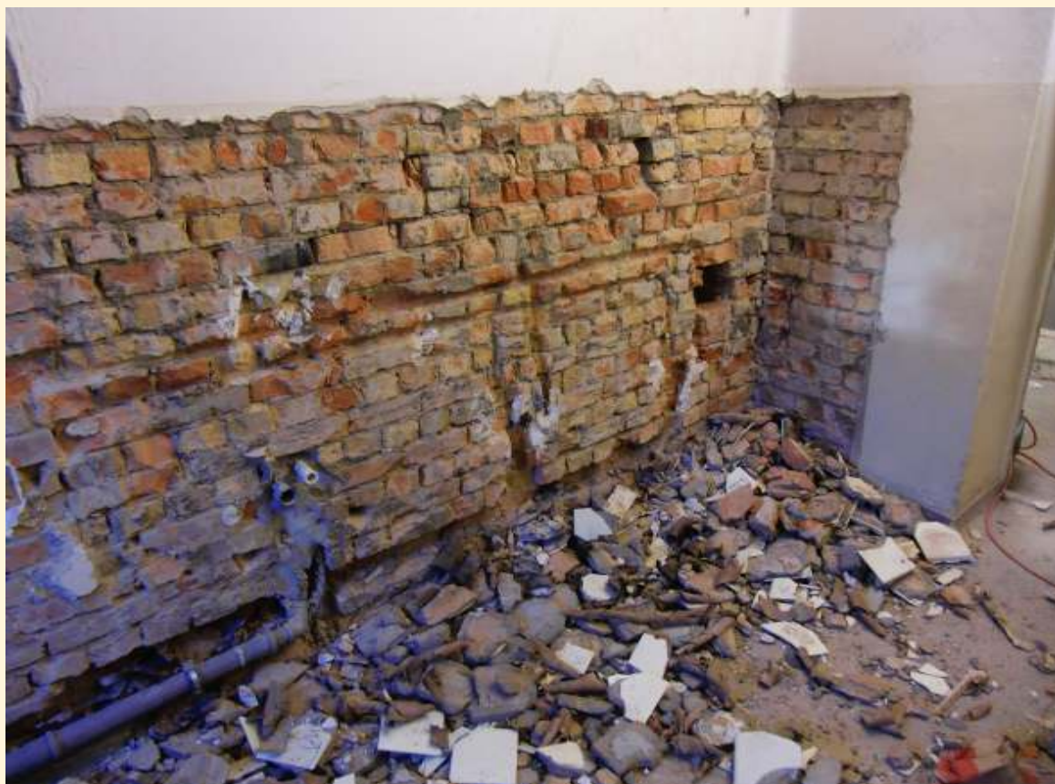
Hier wird gerade die Toilette mit viel Staub und Schutt saniert
