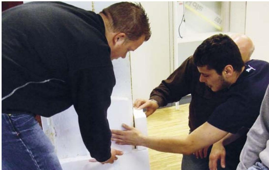
Wärmedämmung an Mauerecken erfordert besondere Sorgfalt: Die Schüler messen auf und bringen die Dämmung an.
