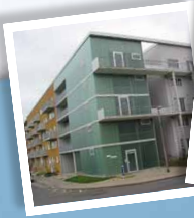
Stadtumbau Leinefelde Eine 60er Jahre Siedlung wird modern
