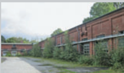
Eingangsfassade Bestand. Foto: Renner Hainke Wirth Architekten GmbH, Hamburg
