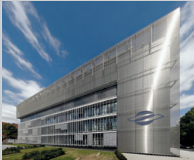
Südfassade. Alle Fotos: Gerhard Kubetschek, Hamburg
