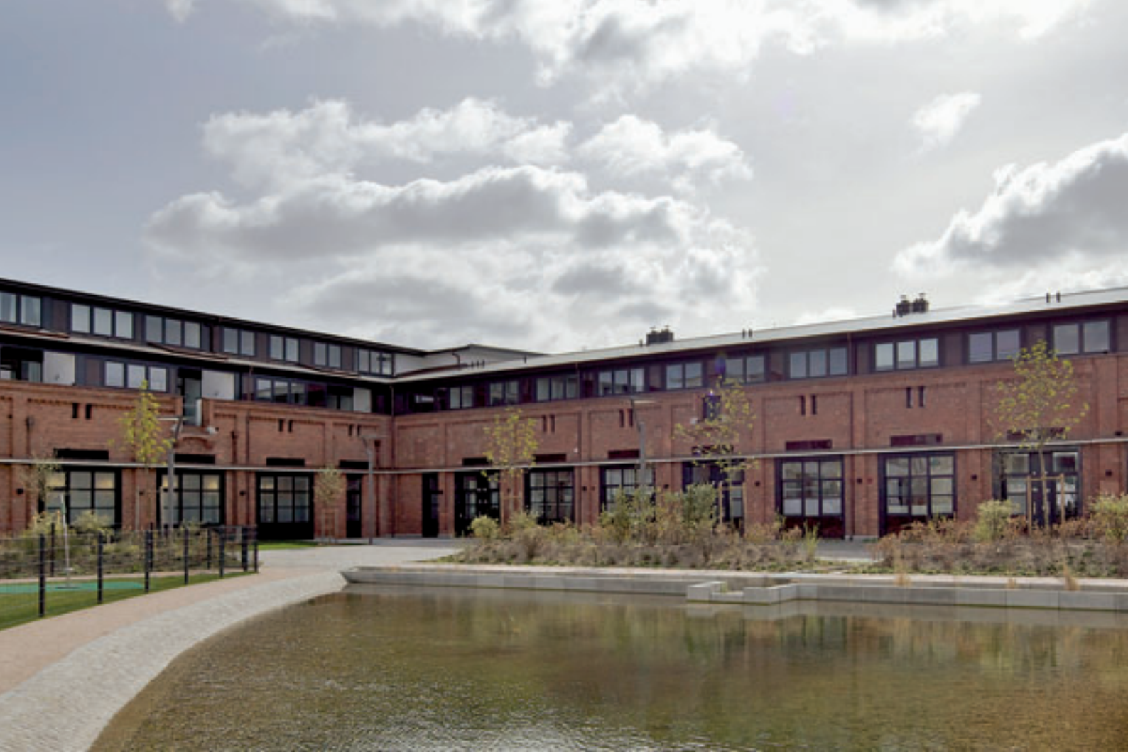
Ansicht Quartiersplatz. Foto: Burkhard Katz, Hamburg
