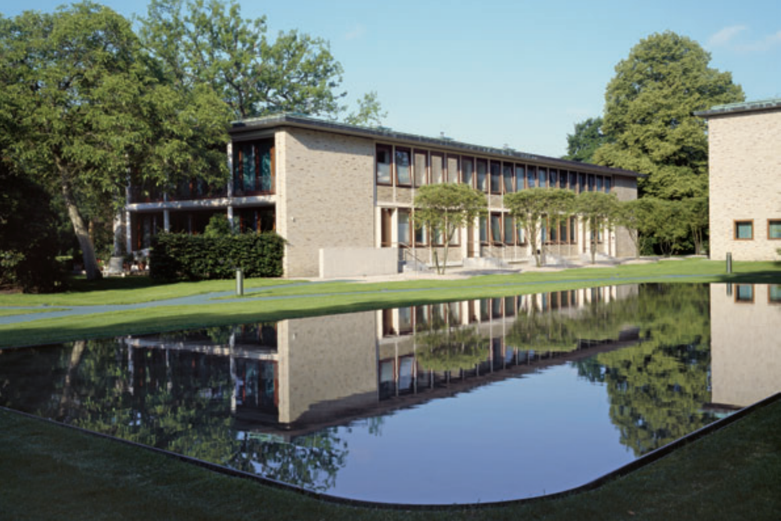
Haus A – Nordfassade. Alle Fotos: Klaus Frahm, Hamburg
