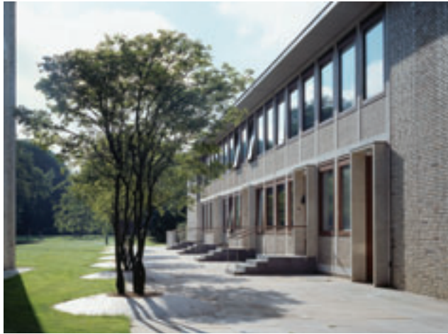
Haus A – Nordfassade mit neuen Eingängen
