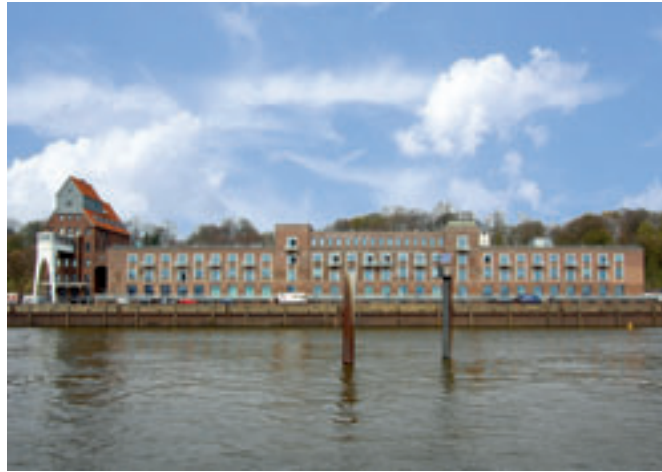
Südfassade vom Wasser
