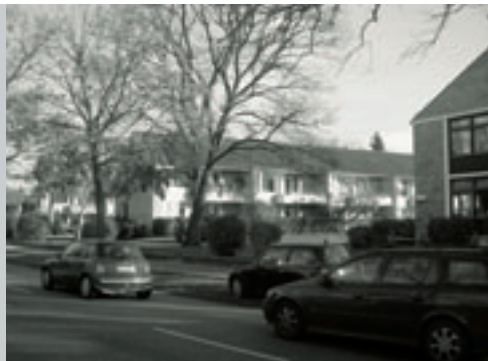
Quartier vor dem Umbau
