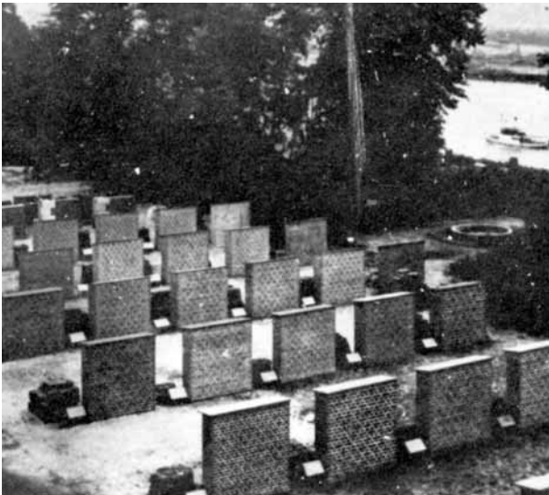
Abb. 7: Büro Gutschow. Testmauern im Garten
