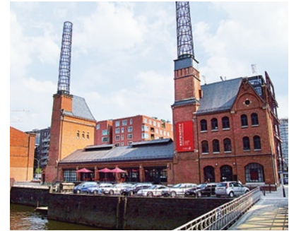
Kesselhaus an der Schwelle zur HafenCity
