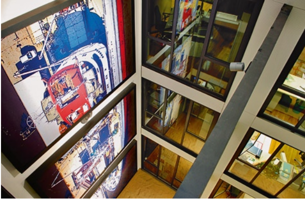
Lichthöfe erschließen die alten Lagerböden wie hier in Block P, der für die Hamburg Port Authority umgebaut wurde.
