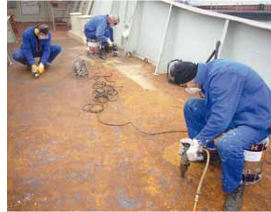
Entrostungsarbeiten an Deck der MS BLEICHEN, seit 2007 wieder in Hamburg
