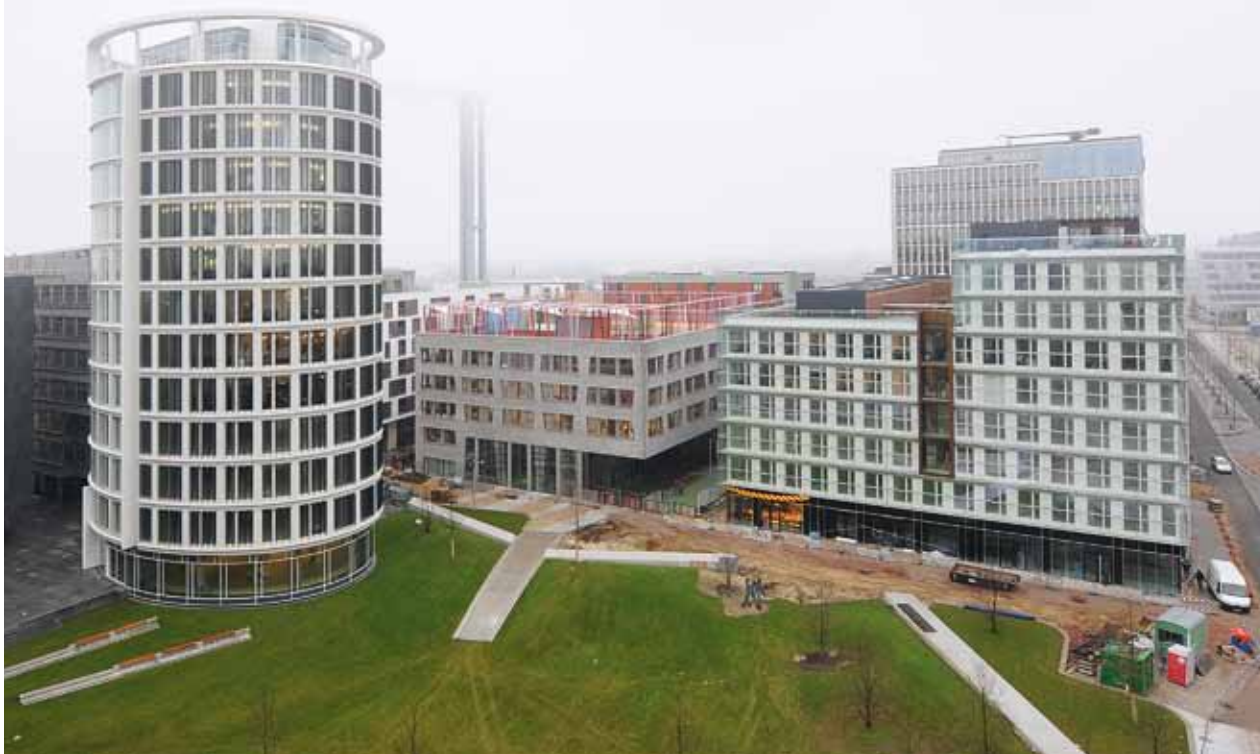
Das Büro- und Geschäftshaus Centurion Commercial Center am Sandtorpark (rechts im Bild) ist bereits zu 85 Prozent vermietet.
