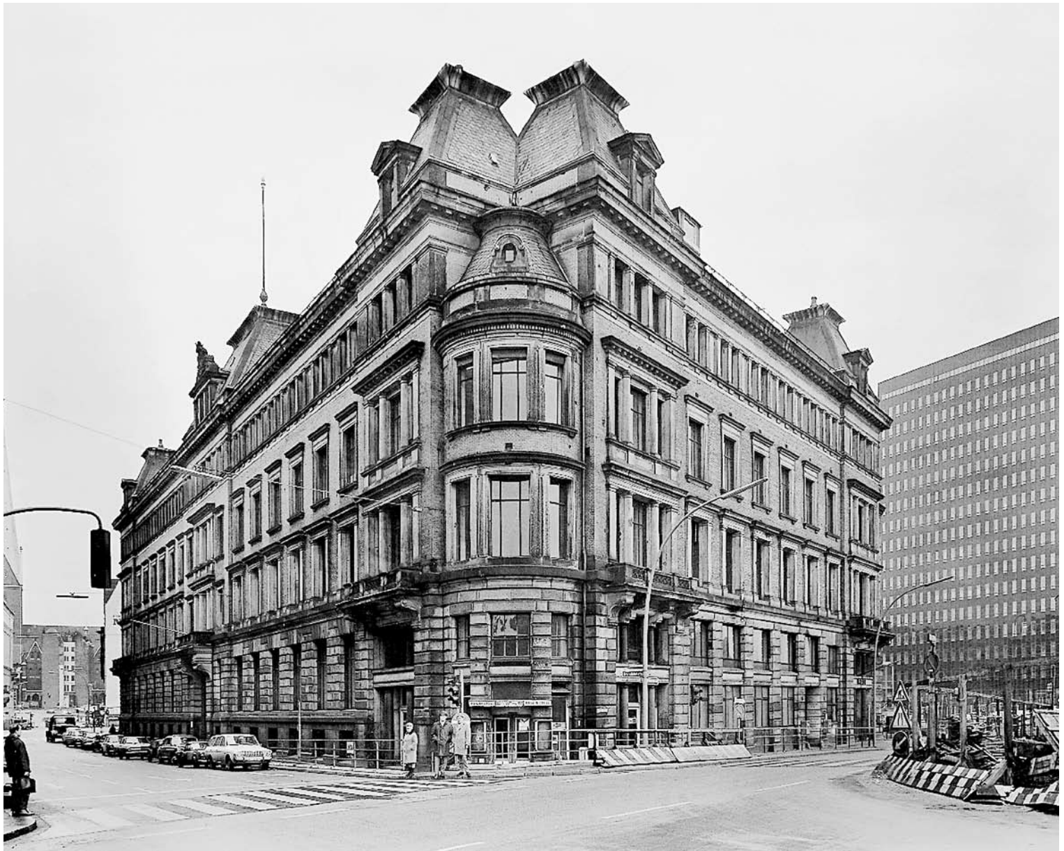
Der Dovenhof von Martin Haller (1885/86) kurz vor dem Abriss (1967).
