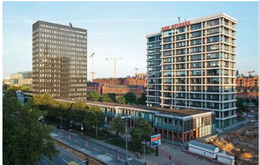
Das IBM-Hochhaus (links) und das Spiegel-Hochhaus von Kallmorgen & Partner (1965–67 bzw. 1967/68). Der Dovenhof stand zum Teil auf dem Gelände der Baustelle vorne rechts.
