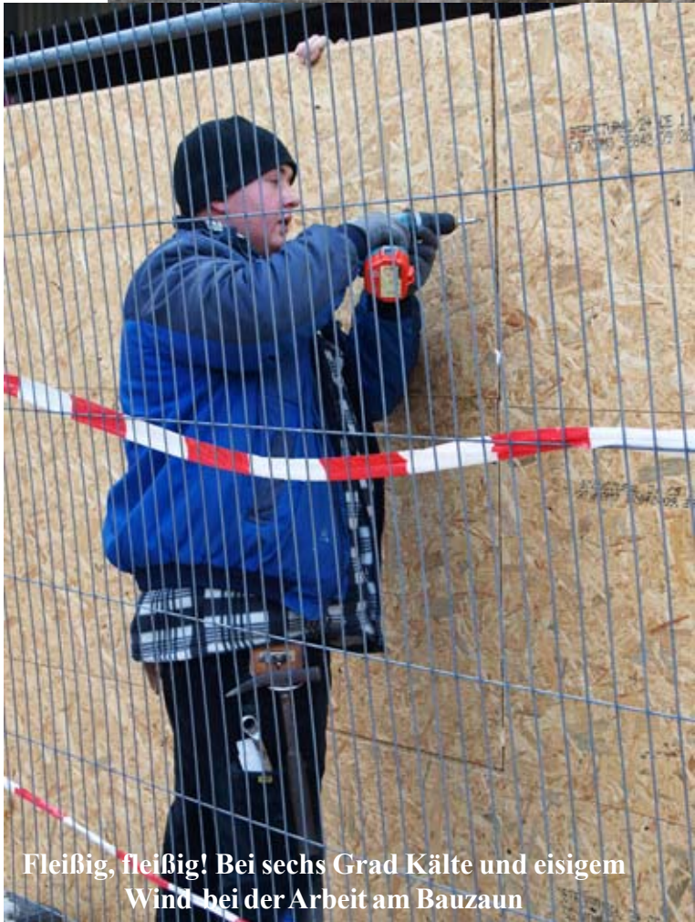
Beim Aufbau des Holzzauns entstand die bemerkenswerte Situation, dass die Baustelle nun gleich von zwei Zäunen gesichert wurde, denn der „Drahtzaun“ wurde erst dann endgültig entfernt, als die Umzäunung insgesamt fertiggestellt worden war
