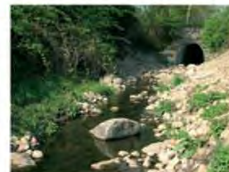
Die Kaskade nach den Umbaumaßnahmen.
