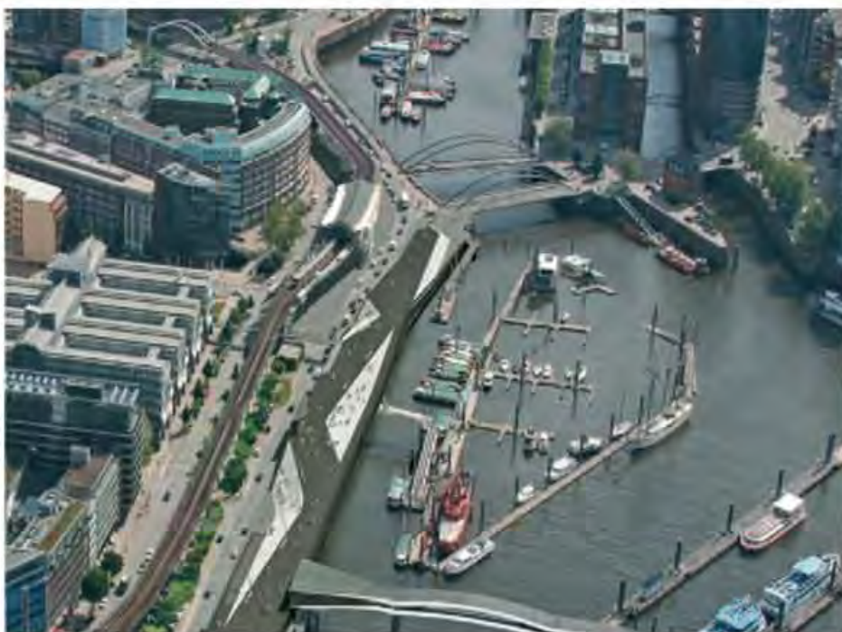
Die geplanten Arbeiten aus der Luft
