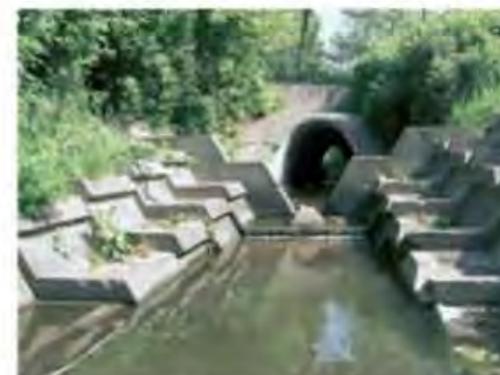
Betonbauwerke werden entfernt.
