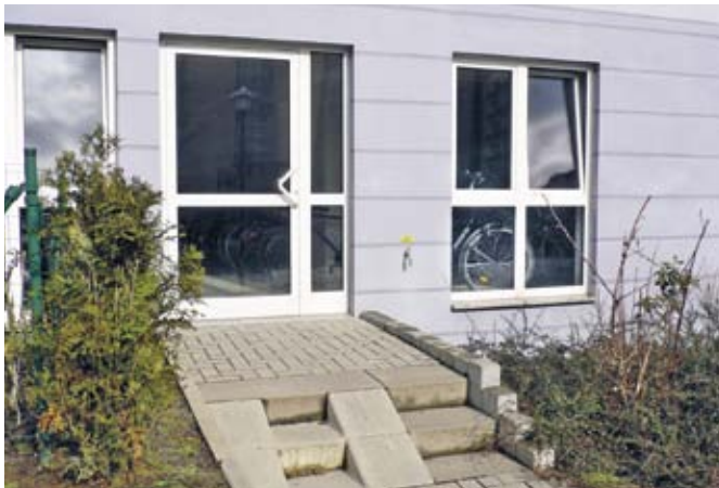
Fahrradraum im Erdgeschoss
