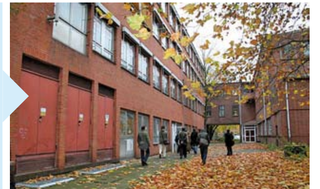
Ansicht der Veringhöfe vor dem Umbau
