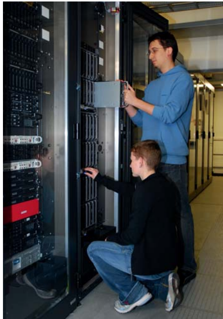
Zwei IT-Mitarbeiter installieren den letzten Rechner der Uni Hamburg für die NAF.
