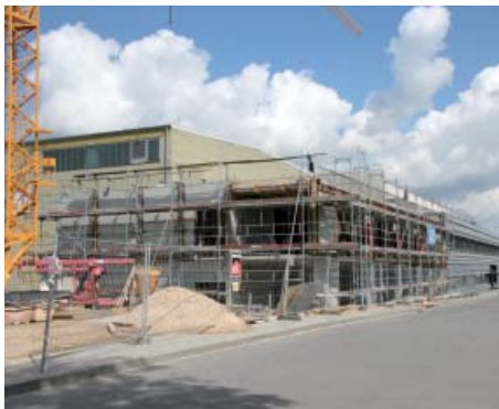
Blick auf die Baustelle von Gebäude 48e.
