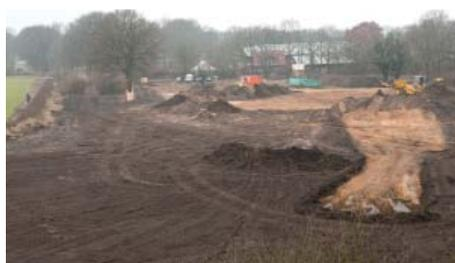
Auf dem Baufeld Osdorfer Born wird der Oberboden abgeschoben. Am rechten Bildrand ist die gelbe Siebanlage zu erkennen.
