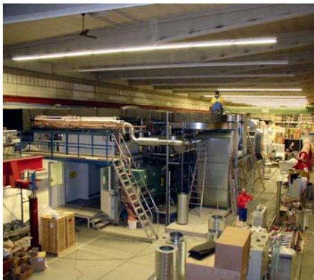
Der Umbau gibt dem Reinraum vor allem von außen ein neues Gesicht.
