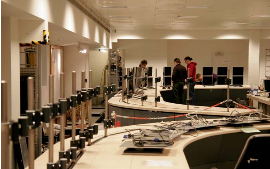
Fast fertig: Die neuen Konsolen stehen schon, nur die Technik muss noch verkabelt werden.
