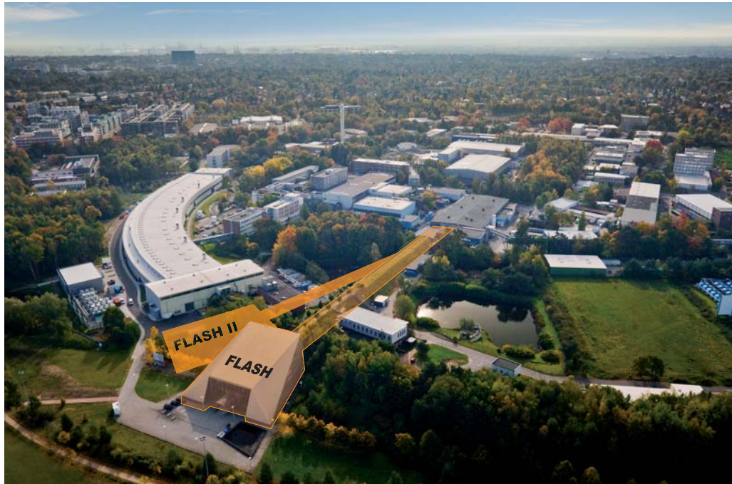
Für FLASH II sollen eine zweite Tunnelstrecke und eine zweite Halle direkt neben die bestehende FLASH-Anlage gebaut werden.
