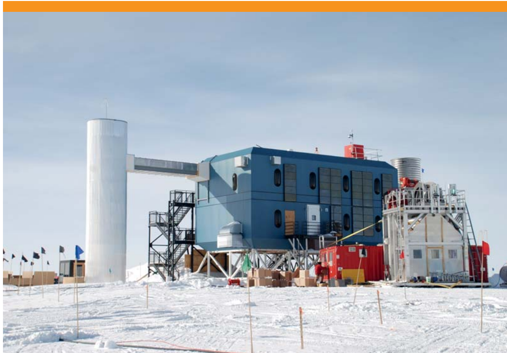
Die Heißwasserbohranlage (rechts im Foto) bohrt hier gerade ein Loch direkt vor dem blauen „IceCube Counting House“, in dem alle Messdaten von IceCube zusammenlaufen.
