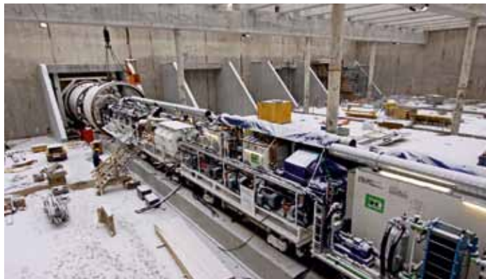
AMELI Anfang Dezember während des Zusammenbaus in der Baugrube für die zukünftige Experimentierhalle
