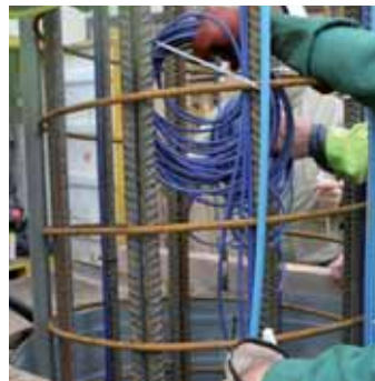
Testvorbereitung: Am Armierungskorb wird umfangreiches Messwerkzeug befestigt.
