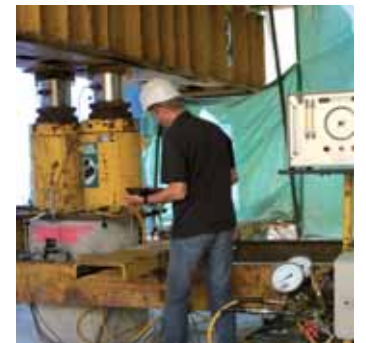
Belastungstest: Oben gegen einen Stahlträger gestützt, drückt die hydraulische Presse auf den Pfahl.
