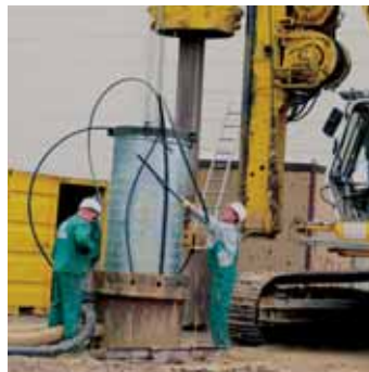
Pfahlbau: Nach der Stahlhülse, kommt das Stahlgitter, (Armierungskorb). Zuletzt wird betoniert.
