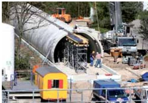
Bei bestem Aprilwetter wird der XFEL-Modelltunnel aus Betonelementen aufgebaut. Jetzt fehlt nur noch die 64 Meter lange Einhausung.
