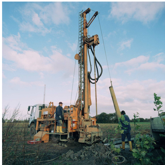
Abbildung 149: Bohrarbeiten zur TESLA-Vorbereitung.
