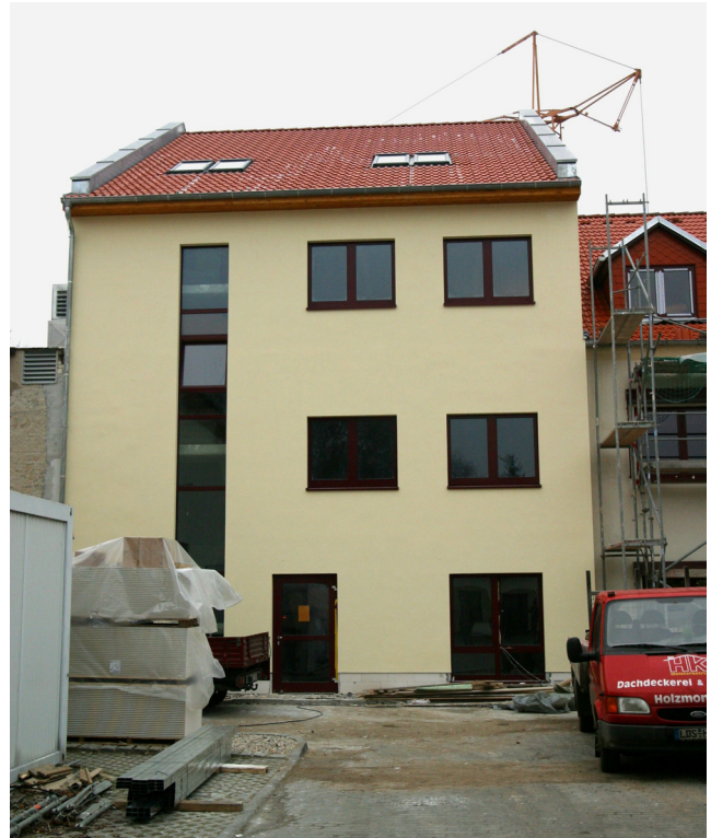
Abbildung 110: Laborgebäude II nach Sanierung und Aufstockung.
