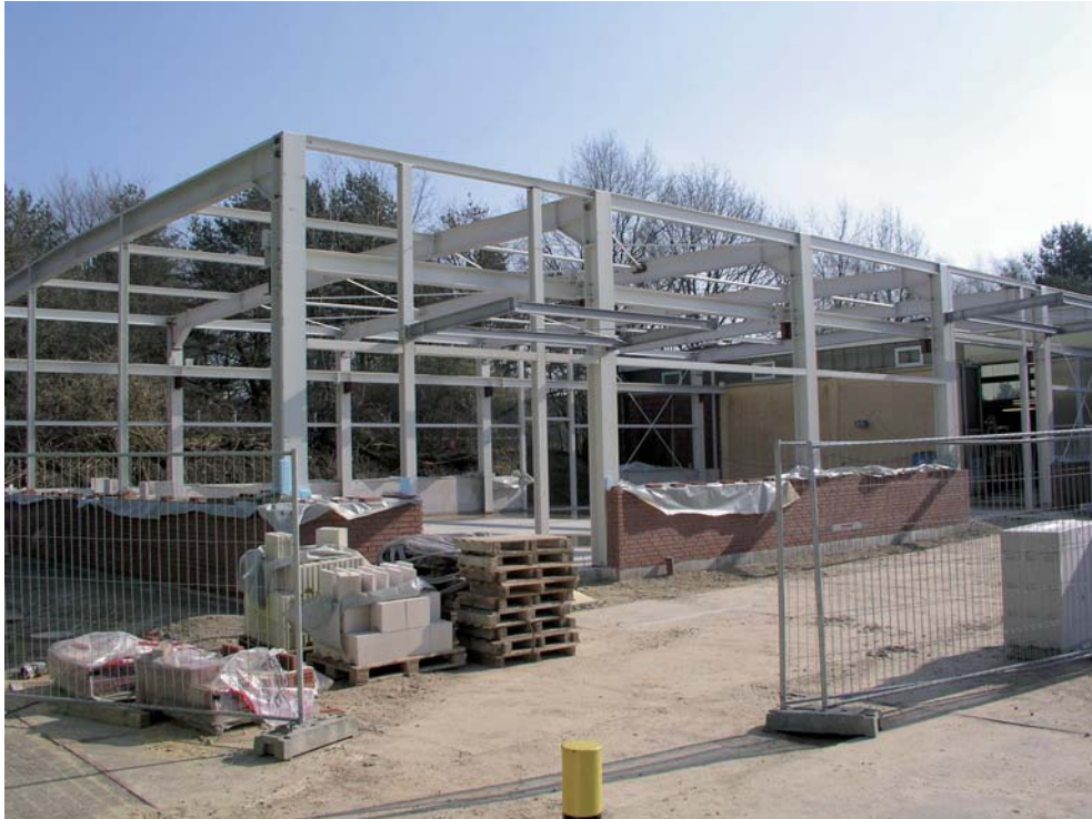
Abbildung 176: Anbau Gebäude 18, Erweiterung der Schweißhalle (rechts).
