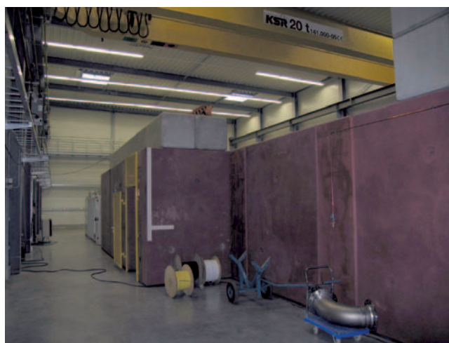
Abbildung 154: In der Modulteststand-Halle sind bereits die ebenfalls 2005 gelieferten Abschirmsteine aus Normal- und Schwerbeton aufgebaut worden. Der Schwerbeton ist infolge des Eisenerzes rötlich gefärbt.
