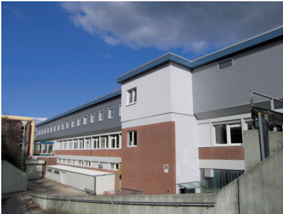
Abbildung 155: Der aufgestockte Bereich wurde mit einer hinterlüfteten Aluminiumfassade verkleidet, die sehr langlebig ist und eine Aufheizung des Gebäudes im Sommer verhindert.
