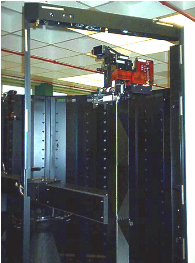
Abbildung 152: Robot während der Installation.
