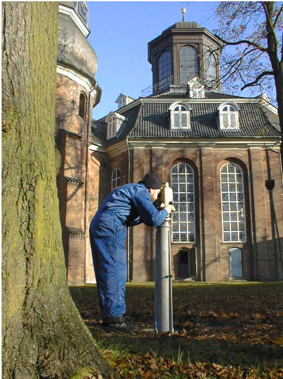
Abbildung 143: Sicherungsmessungen an der Rellinger Kirche.
