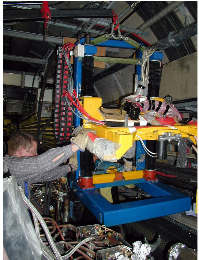
Abbildung 148: Einbau des Hubtisches für den H1-Photonendetektor.
