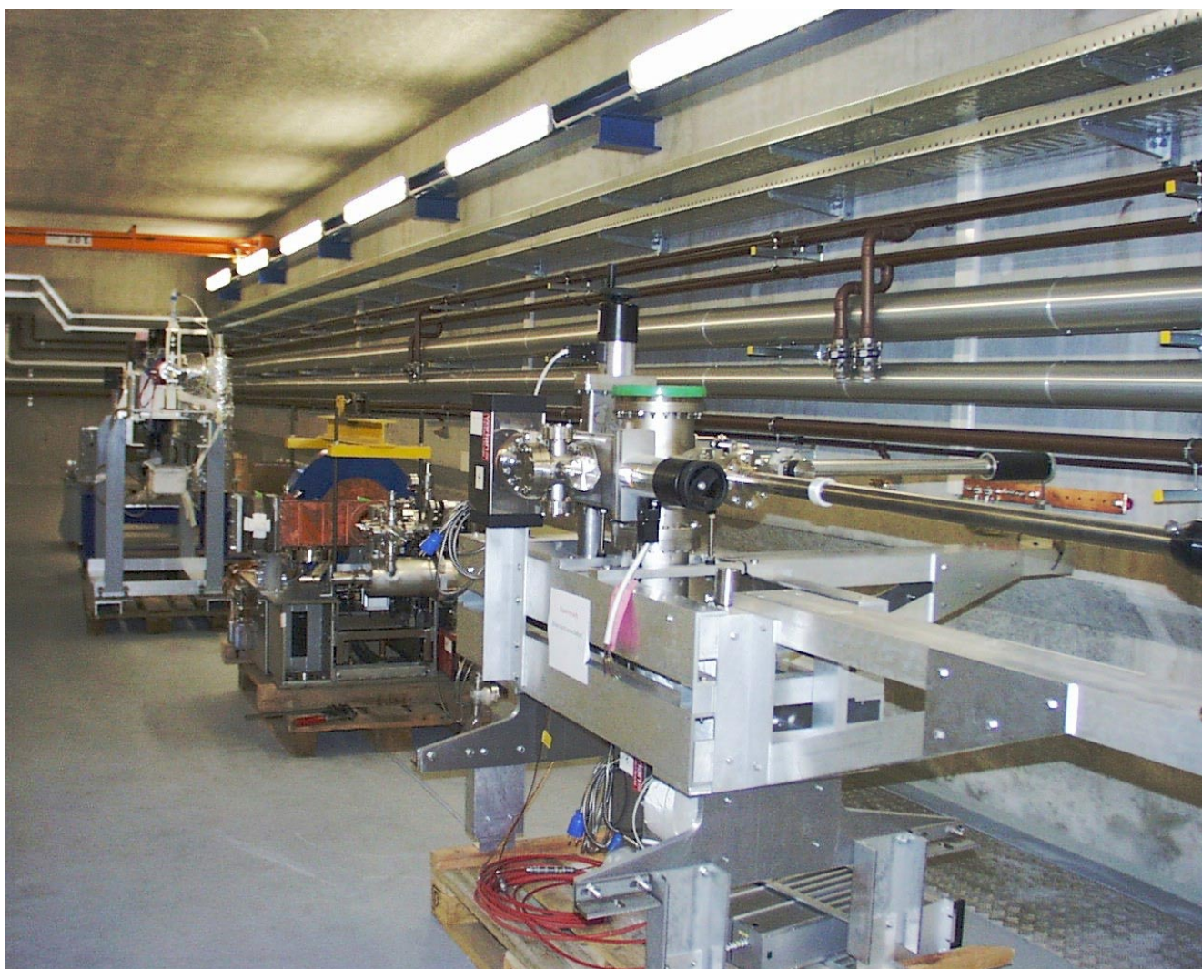
Abbildung 85: Stand des Aufbaus des PITZ-Injektors.
