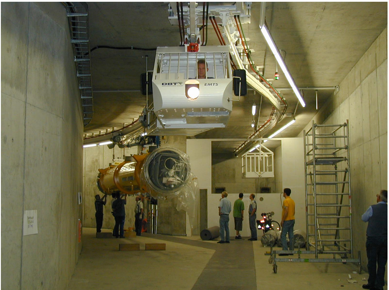
Abbildung 128: Einbau eines Beschleunigermoduls im TTF-Tunnel.
