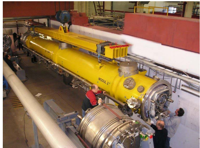
Abbildung 127: Einbau des Kryomoduls 2* in den Injektorbereich des VUV-FEL LINACs (Position ACC1).
