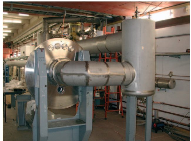
Abbildung 116: Kryogenische Komponenten im TTF-Tunnel.
