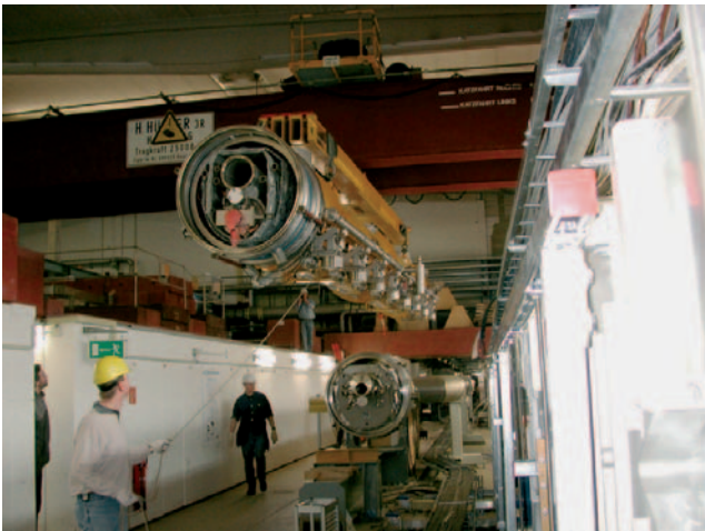
Abbildung 115: Installation des Kryomoduls Nr. 3* im TTF-Tunnel.
