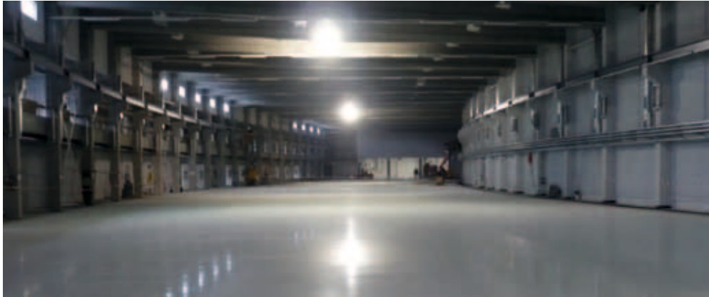
Die wahrscheinlich längste Betonplatte der Welt – zumindest die längste meterdicke und in einem Stück gegossene!
