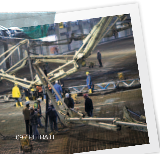
Drei Tage lang waren die Betonarbeiter rund um die Uhr im Einsatz.
