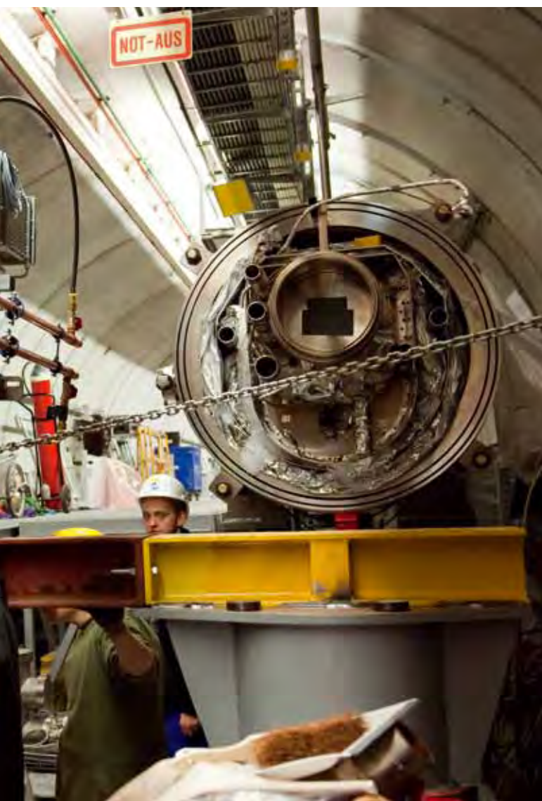
● Einbau eines Beschleunigermoduls in den Freie-Elektronen-Laser FLASH
