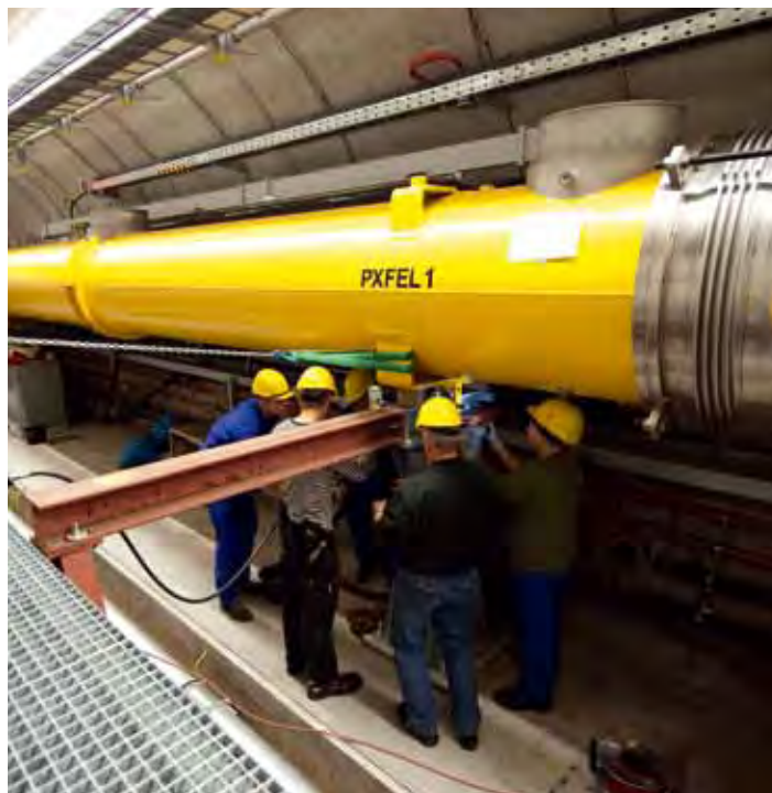
● Ein Beschleunigermodul enthält je acht auf minus 271 Grad Celsius gekühlte supraleitende Resonatoren.
