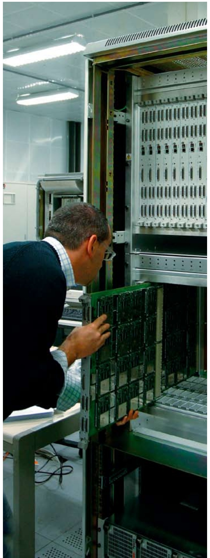
● Installation eines apeNEXT-Systems bei DESY in Zeuthen
