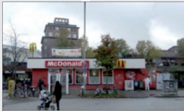
Dieser „Zustand“ bleibt !
