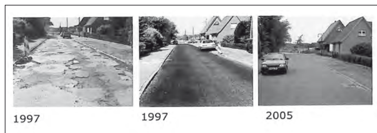
Beispiel für den Einsatz eines Dünnschichtverfahrens. Quelle: ADAC-Workshop 2006 „Straßenerhaltung“
