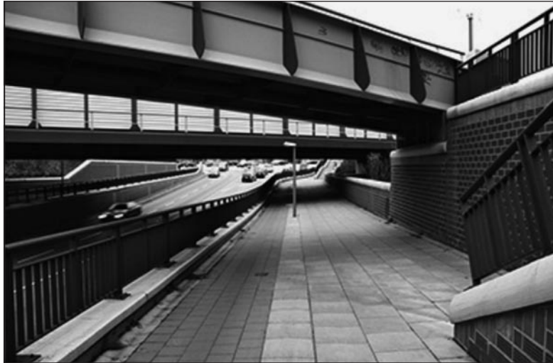
Blick auf die Straßenunterführung von Süden
