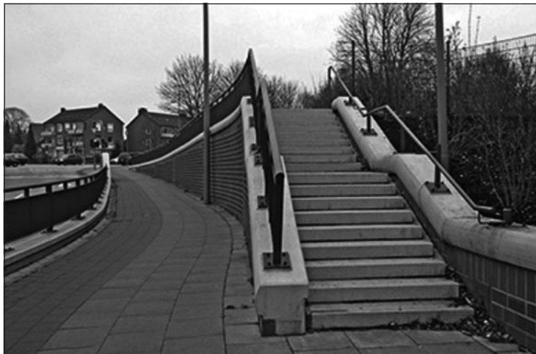
Treppe an der Nordostseite
