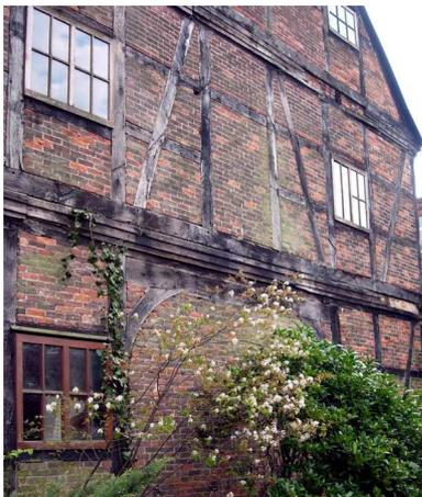
Der Speicherkomplex entstand 1827 als Ergänzung des alten Harburger Kaufhauses und wurde 1881 verschoben und gedreht, um einer Eisenbahnlinie Platz zu machen. An den zweigeschossigen Fachwerkbau mit seinen drei Lagerböden wurde 1888 ein eingeschossiger Putzbanbau mit Segmentfenstern angebaut, der als "Comptoirgebäude" (Kontorgebäude) diente. Das Gebäude diente viele Jahrzehnte als Speicher der Lebensmittel- und Samengroßhandlung Bode & Kroos und steht derzeit leer.
