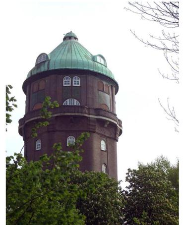
Der Turm besaß eine für damalige Zeiten hochmoderne Gebäudetechnik. Ein Wasserbehälter mit halbkugelförmigem Boden in Hängebodenbauweise hat ihm dabei eine besonders schlanke Silhouette verliehen. Mit einer Gesamthöhe von 46 Metern und einer Wasserstandshöhe von rund 40 Metern überragte der Turm die zur Bauzeit gültige Höchstlage von Obergeschossetagen um 17 Meter und sicherte damit einen ausreichenden Wasserdruck.
